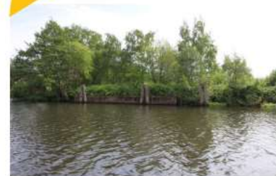
Naturnahe Gestaltung von Ufern Konsequenz: Rückbau von Mauern und Spundwänden
