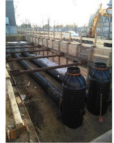
Sedimentationsrohre an der Köhlbrandbrücke
