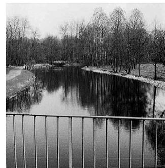
Abb. 3.2 – Die Alster im Jahr 1975. Die mit Faschinen und Geröllschüttungen begradigten und befestigten Ufer galten damals als „einwandfreier Zustand“. Eine natürliche Dynamik mit Prall- und Gleithängen konnte sich hier nicht ausbilden. Heute wird wieder etwas mehr Dynamik an der Alster zugelassen (vergl. Abb. 2.4 und 2.5)
